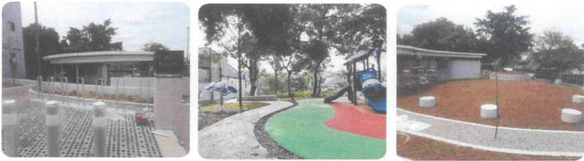
Gambar 13. Pembangunan RTH Taman Melati (Jl. AUP Barat No.1 RT 009/06, Kelurahan Jatipadang, Kecamatan Pasar Minggu, Jakarta Selatan)
