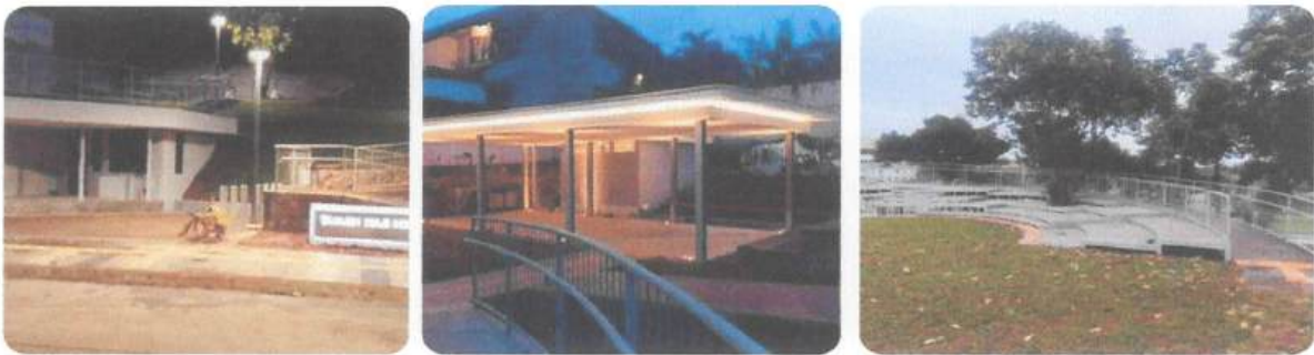
Gambar 12. Pembangunan RTH Taman Haji Niman (Jl. Lebak Bulus V RT.07 RW.04, Kelurahan Cilandak Carat, Kecamatan Cilandak, Jakarta Selatan)
